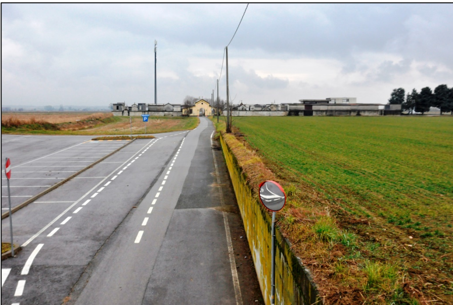
UR_01: foto UR_01 c: particolare della strada Comunale del Cimitero, che costeggia, ad una quota molto più bassa, il lato nord-orientale dell'UR_01. Scatto da nord-ovest.
