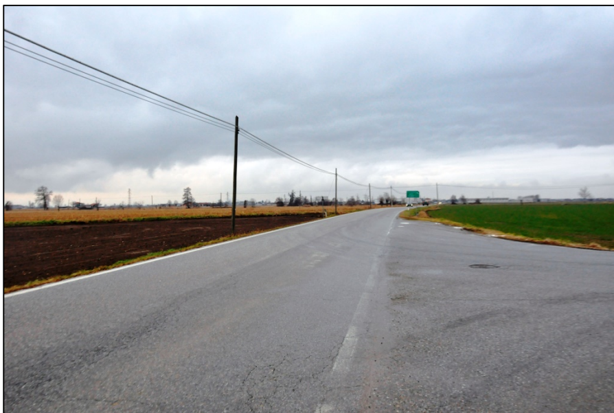
UR_06: foto UR_06 b: panoramica del tratto di intersezione tra la strada SP 43 e il piazzale dello stabilimento Dentis. Scatto da nord-est.
