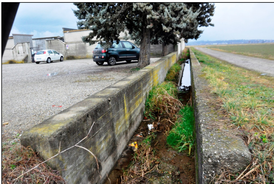
UR_02: foto UR_02 b: particolare del canale a cielo aperto con sponde in cemento che costeggia il lato sud-est del cimitero. Scatto da sud-ovest.
