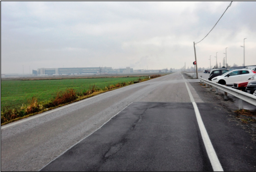
UR_10: foto UR_10 b: panoramica del tratto centrale della strada SP 43. Scatto da nord-ovest.
